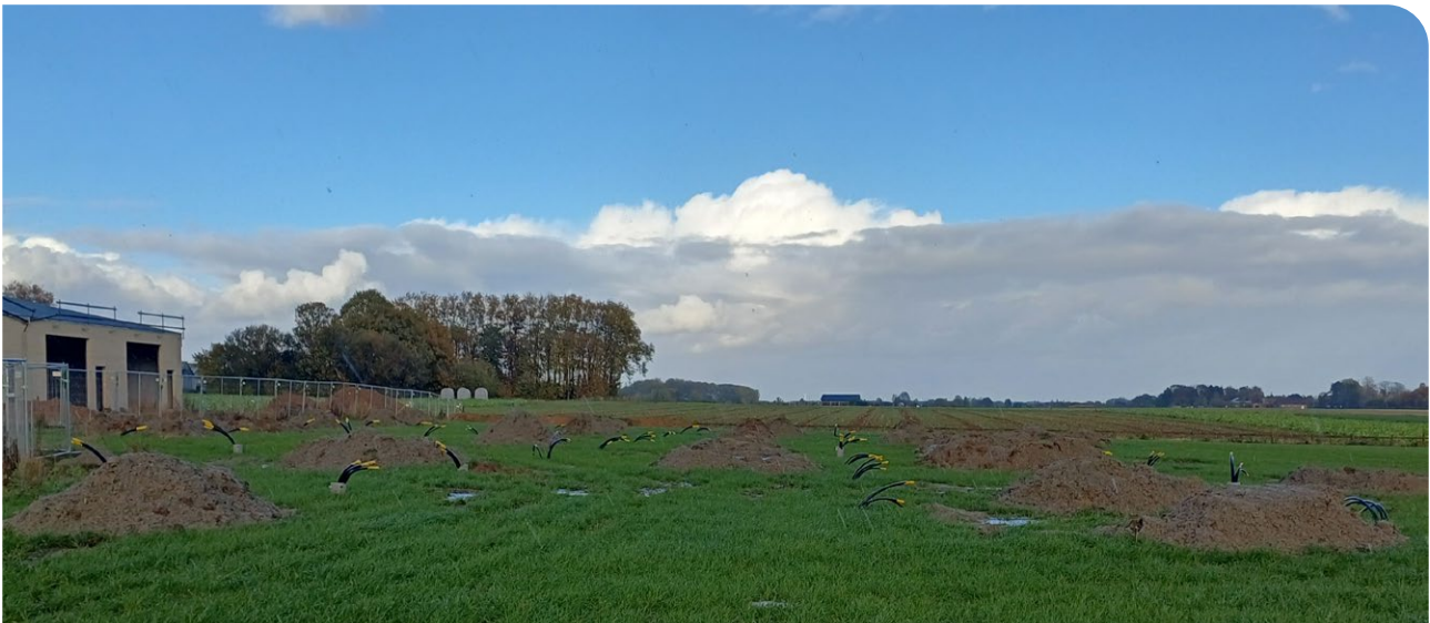
Figuur 13: werf na het plaatsen van de boringen en de bodemlussen
