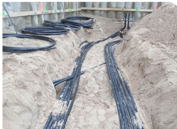
Figuur 15: sleuf met de HDPE-leidingen
