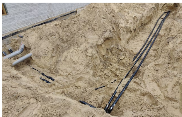
Figuur 16: Tichelmann-aansluiting van 2 boringen
