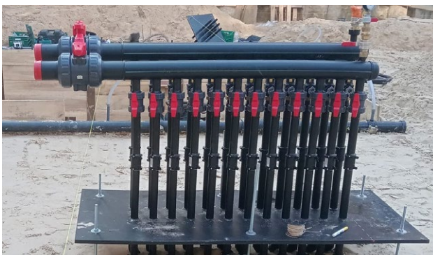
Figuur 19: kimplaat na aansluiten, plaatsen collectorbalk en vullen sleuven
