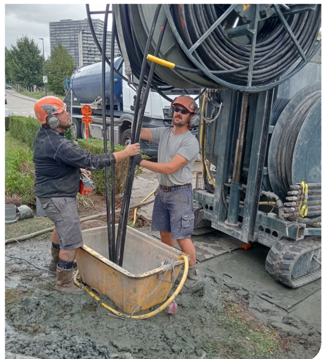
Figuur 12: plaatsen bodemlussen (sondes) en grouten
