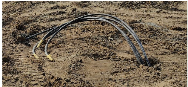
Dubbele sonde (lus)
