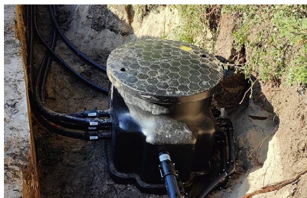
Figuur 17: kunststof collectorput voor 4 boringen
