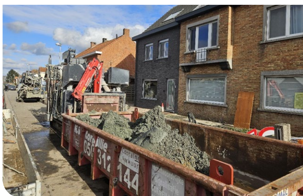
Figuur 8: afvoeren boorresten
