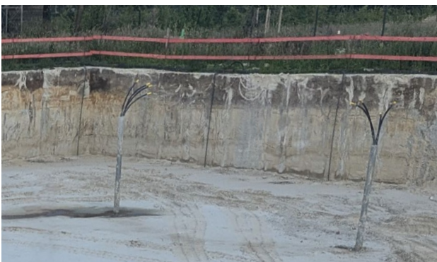
Figuur 14: PVC buizen rond de sondes, zichtbaar na afgraven
